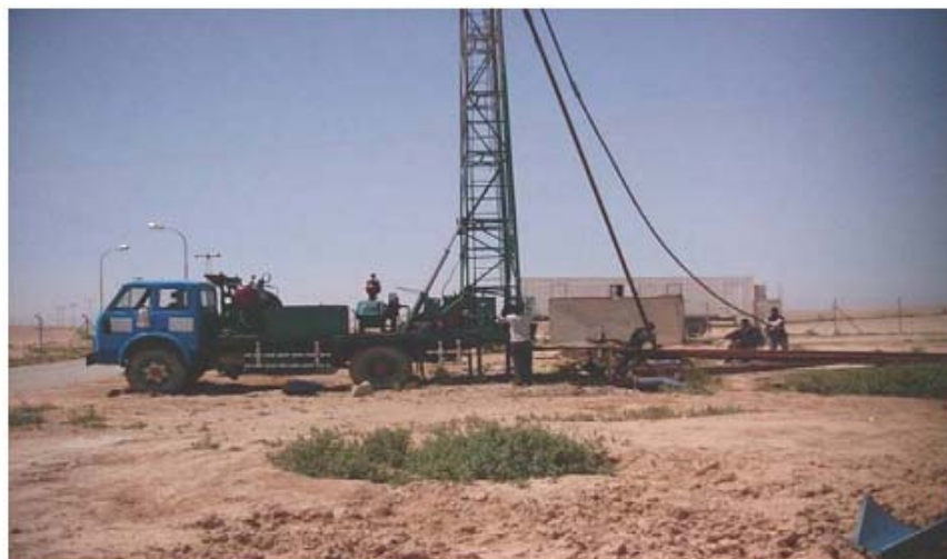
Figura H5: Rehabilitación de un sondeo para observación del nivel de agua en la CAZ
